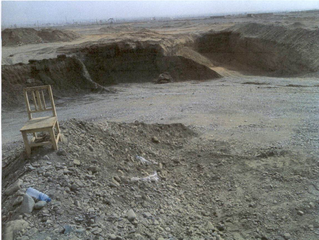
施工治理前照片
