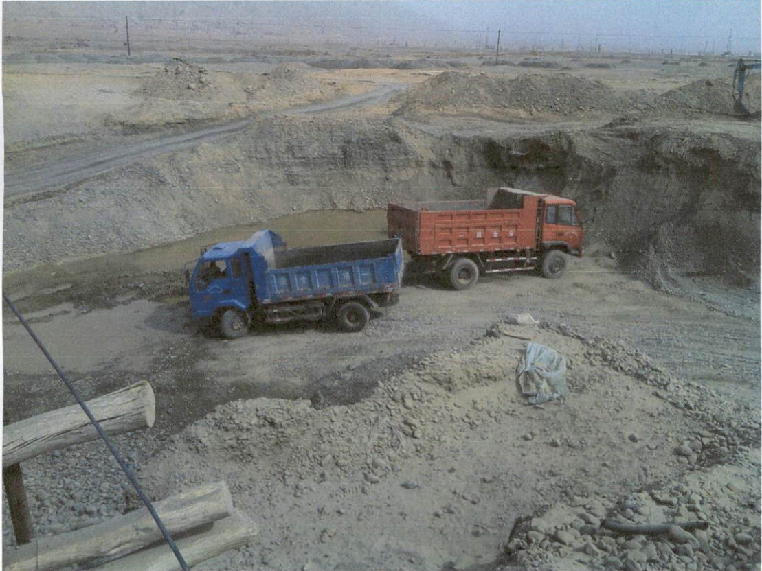
施工治理前照片
